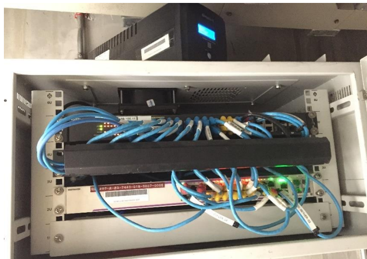
รูปที่ 4.21 แสดงการติดตั้ง Switch Access หอพักเพชรรัตน์ 1
